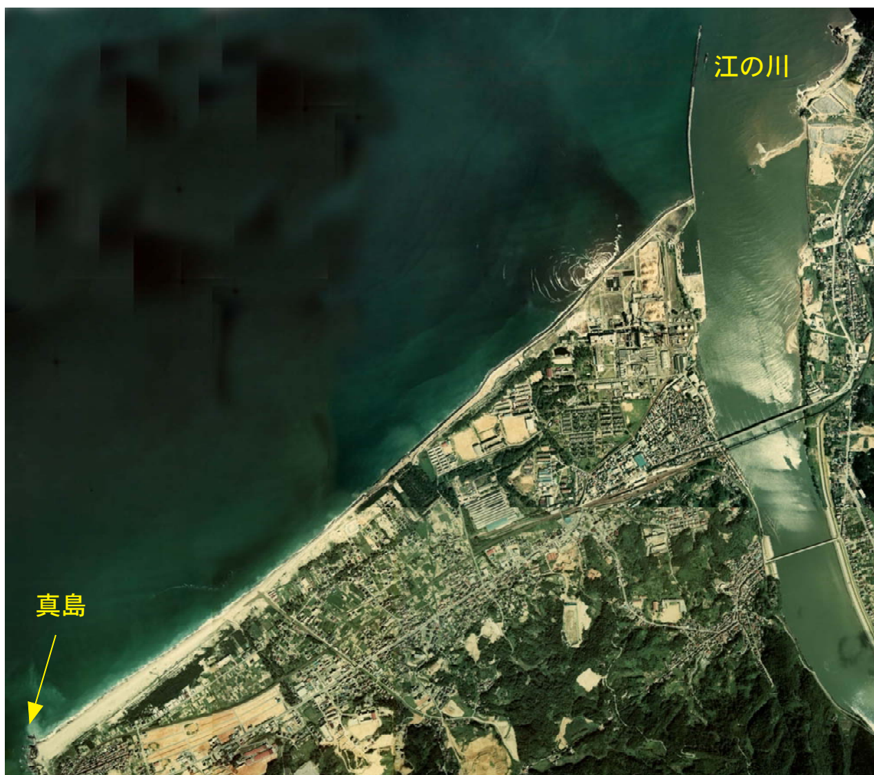
写真-2. 江津海岸の空中写真（昭和 51 年）[国土交通省，国土画像情報サービスより]
