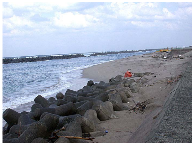
写真-11.江津海岸に並べられている消波ブロックの西から1-2番目の間から東側を見た江津海岸（③）
