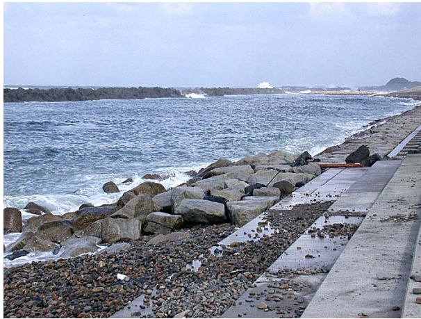
写真-13. 江津海岸中央付近 (④) から、東側を望む。砂利浜である。砂利がコンクリート階段まで打ち上げており、波が強いことを物語っている。
