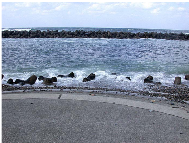
写真-14. 江津海岸中央付近正面 (④)。足下はコンクリートで整備されている。
