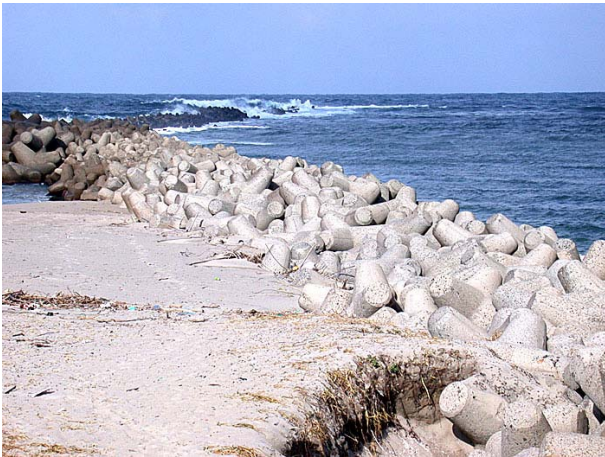
写真-19. 江津海岸沿いの道路と浜の防波堤最東端からの江の川 (写真左側) テトラポットと群. テトラポットの右側は, 江の川
