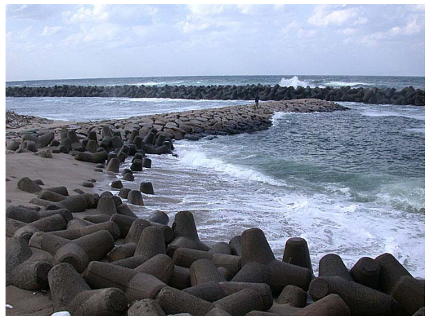
写真-17. 真島側から江津海岸沿いに走っている側道の行止り前の状態.. 道路に直角に延びた防波堤。釣りをしている人がいた。写真手前は道路側のテトラポットである。
